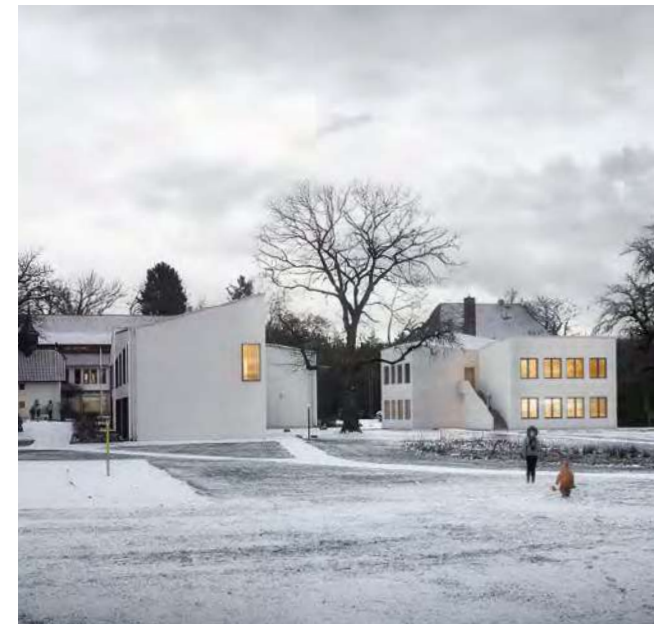
Das neue Mittelstufenhaus , bestehend aus vier modernen Klassenzimmern sowie einem großzügig gestalteten Freiarbeitsbereich. Geplante Fertigstellung: Spätsommer 2019
